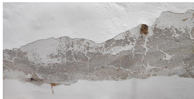
รูปที่ 1 ร่องรอยความเสียหายของกำแพงที่มีความชื้น
