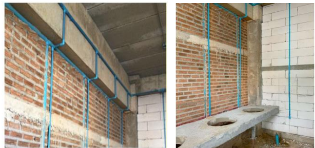
รูปที่ 1 ตัวอย่างการเดินท่อในแนวตั้งของระบบสุขาภิบาล
